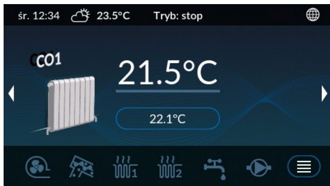
Ilustracja 16: Ekran obwodu CO.1
